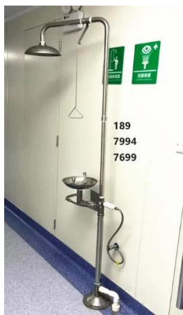
图 7-1 紧急冲淋装置
